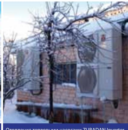
Отопление тепловыми насосами ZUBADAN Inverter
